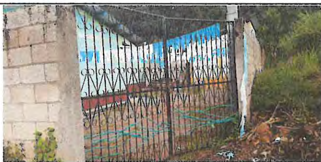
Foto 5: Mantenimiento de portón de metal, lijado, pintado y soldado
