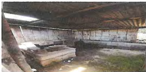
Foto 3: Sustitución de soporte de madera por metal, en cocina
