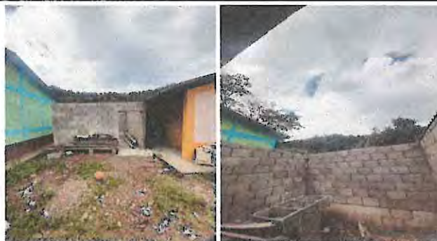
Foto 4: Implementación de repello y cernido de paredes
