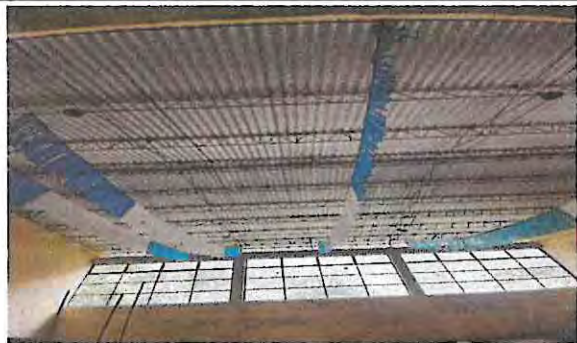
Foto1: Sustitución de lamina acanalada por lamina troquelada, en Salón No. 3
