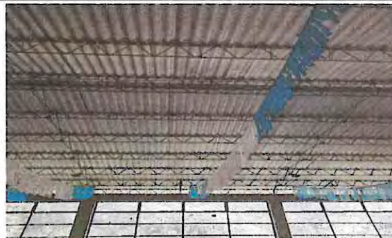
Foto 2: Mantenimiento de estructura de soporte de metal lijado pintado y reforzado en Salon No. 3
